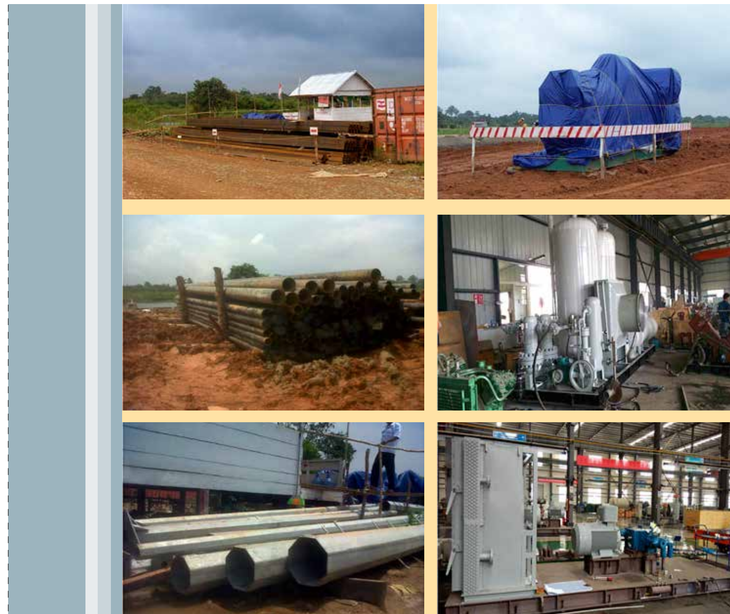
Gambar Progres Pembangunan Kilang Mini LPG di Sekayu Musi Banyuasin Progress of LPG Mini Refinery in Sekayu Musi Banyuasin
