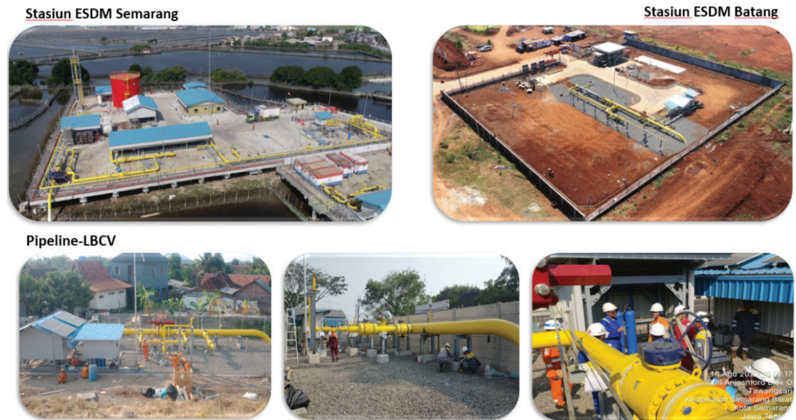
Gambar 2.24 Dokumentasi Pembangunan Pipa Transmisi Gas Bumi Cirebon – Semarang (CISEM)
