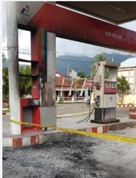
Gambar 1. Kondisi shelter yang terbakar
