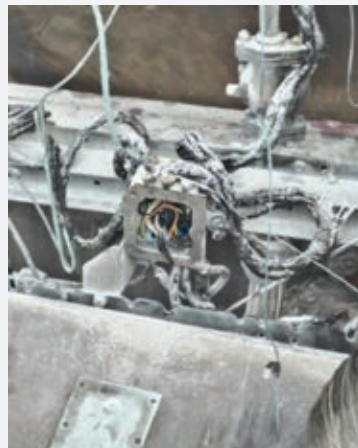
Gambar 3 Sambungan kabel yang seharusnya berada dalam junction box tertutup kuat [explosion type]
