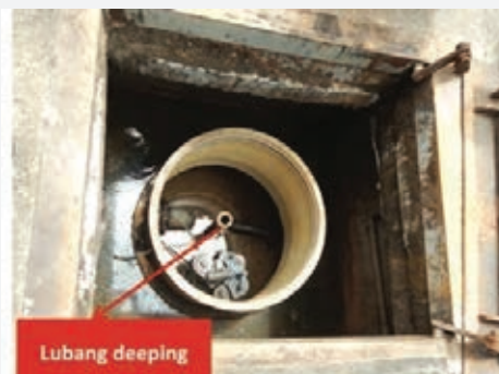
Gambar 3. Lubang deeping BBM yang terbuka katupnya
