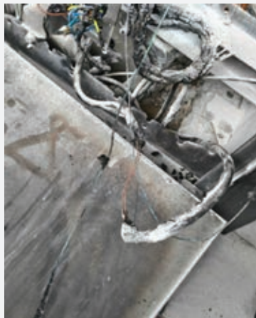
Gambar 3 Sambungan kabel yang seharusnya berada dalam junction box tertutup kuat [explosion type]
