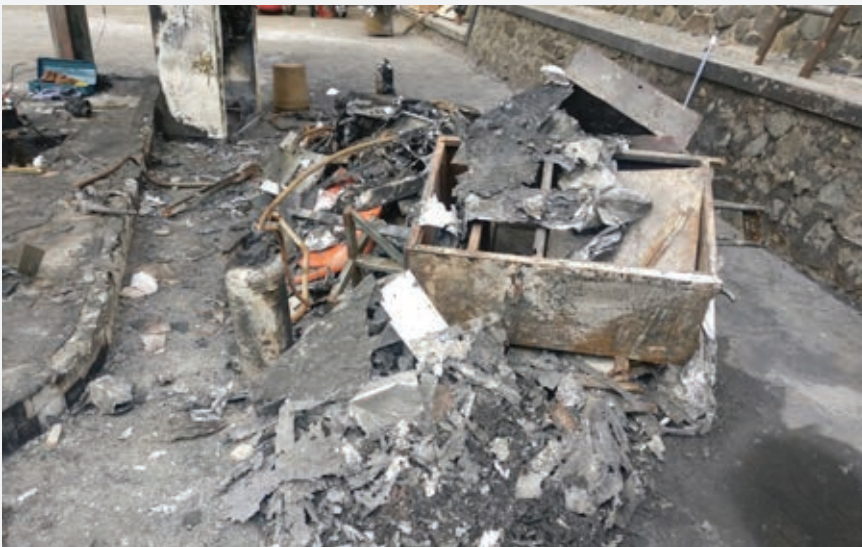
Gambar 4. puing puing motor, plafon dan dispenser spbu yang terbakar
