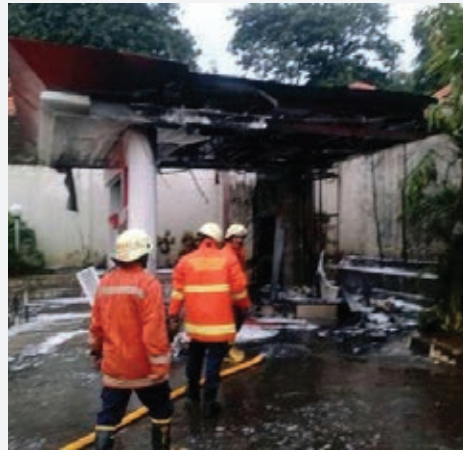
Gambar 5. Kebakaran SPBU di Jalan Raya Penggilingan Cakung, Jakarta Timur
